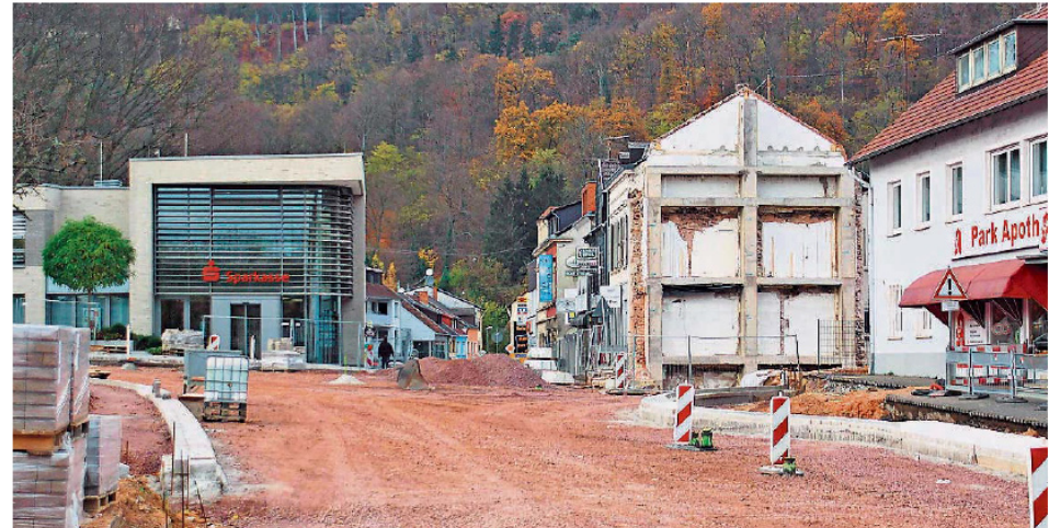
Ein betonierter Stützrahmen (rechte Bildhälfte) erinnert an den Standort des ehemaligen Café Kiefer; rechts unten ist die neu entstehende Busbucht erkennbar. FOTOS: J. BODWING
