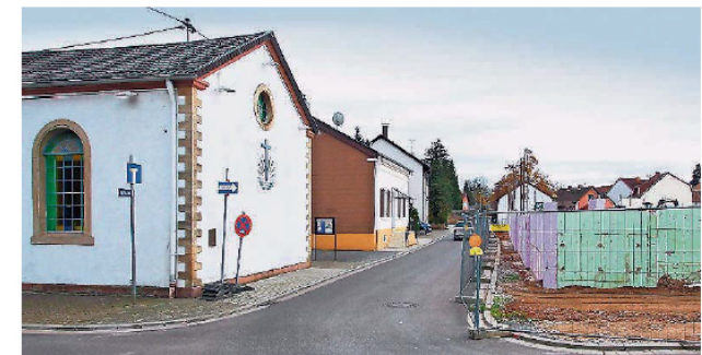
Die Baustelle an der Ecke Saarstraße-Gartenstraße.
