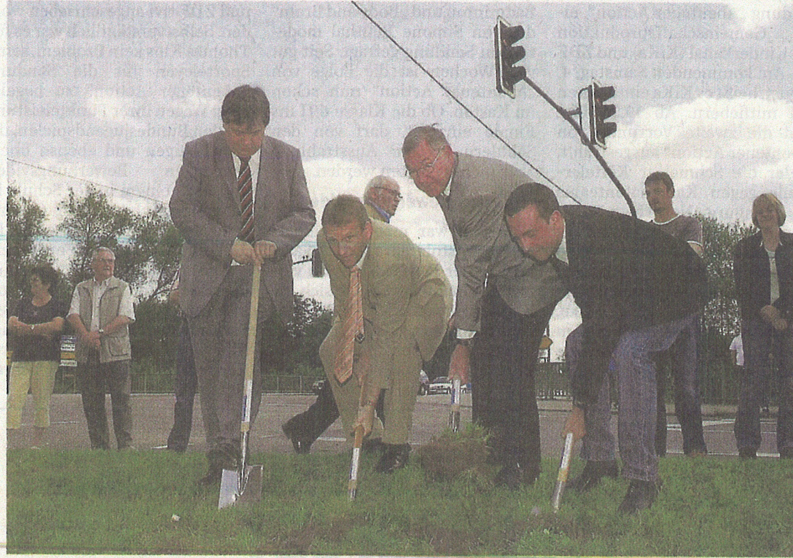
Der Kreisel ersetzt die Ampel-Anlage an der Primsbrücke. Es packten an: LfS-Chef Hanke, Bürgermeister Lauer, Wirtschaftsminister Georgi und der Landtagsabgeordnete Schmitt. Foto: Thomas Seeber
